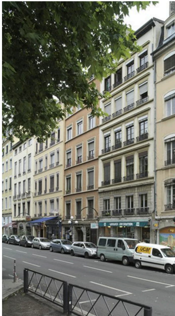
Partie sud du quai Saint-Antoine
