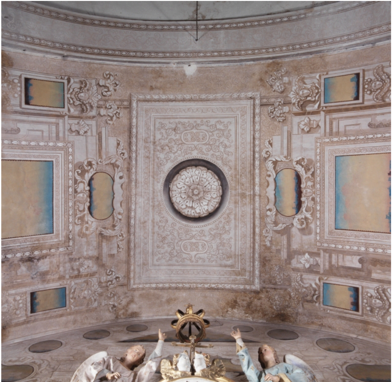
Partie centrale de la voûte.
