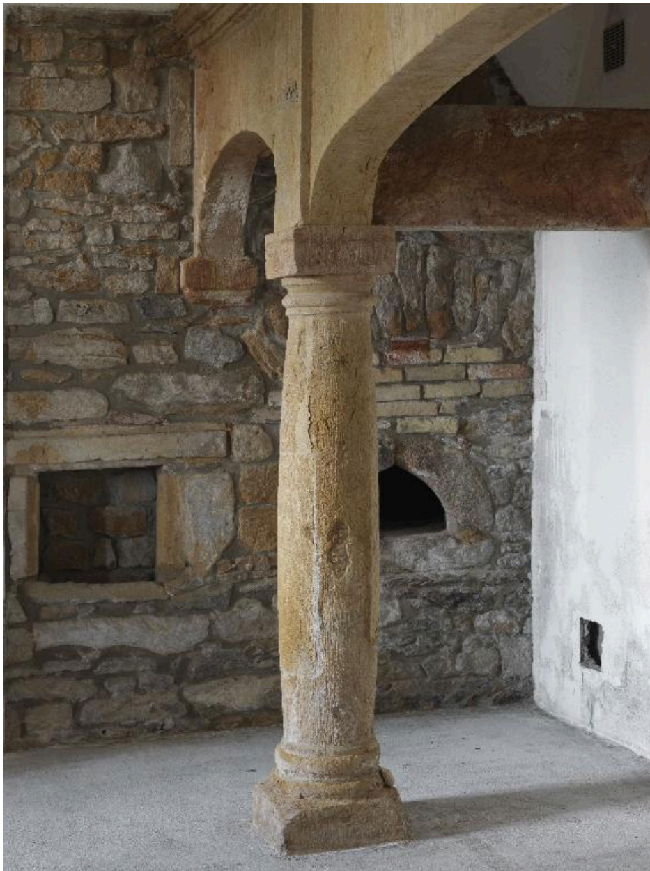
Ancienne cuisine au rez-de-chaussée : détail d'une colonne de la cheminée
