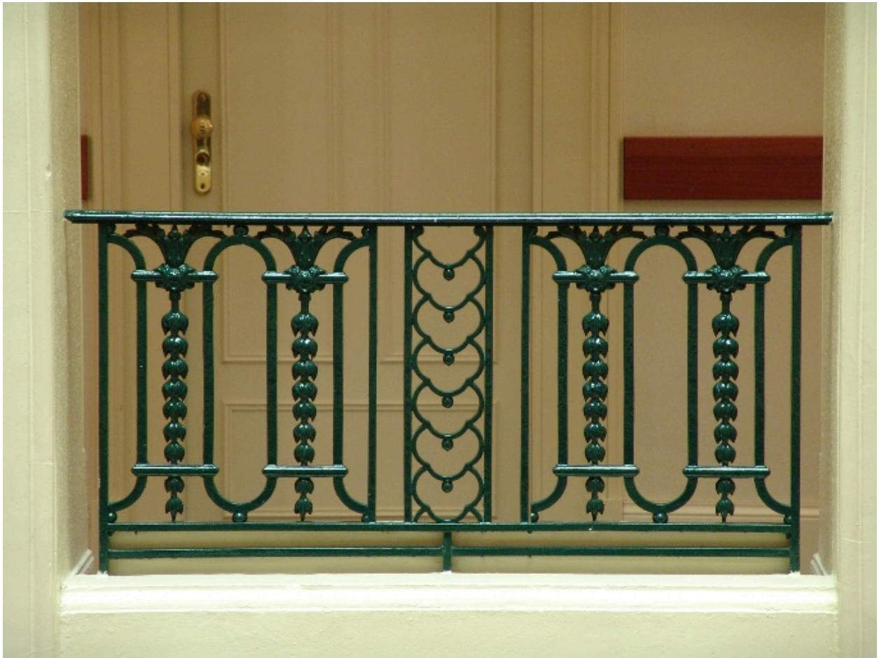
Atrium : garde-corps du 2e étage
