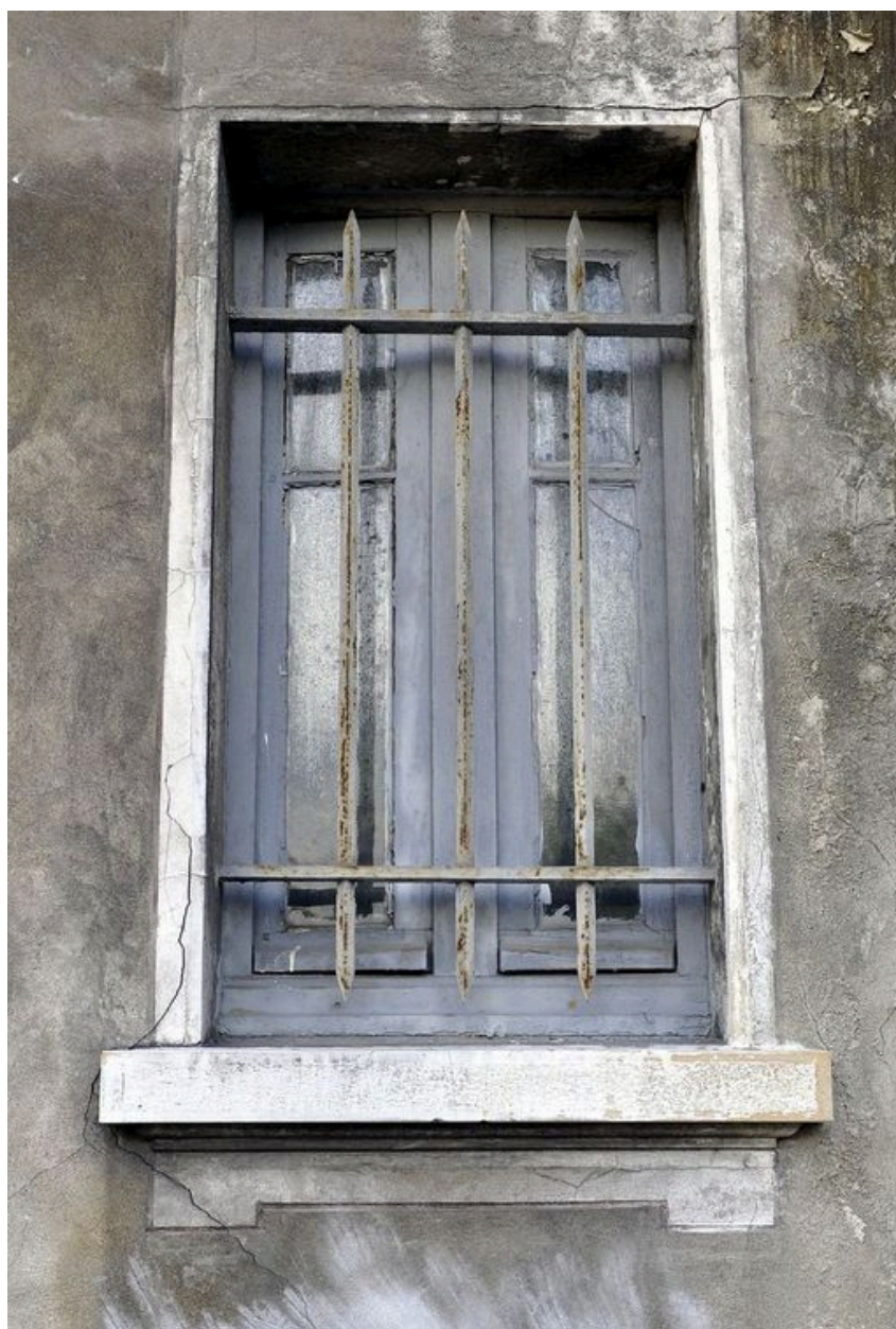
Façade postérieure, baie du rez-de-chaussée
