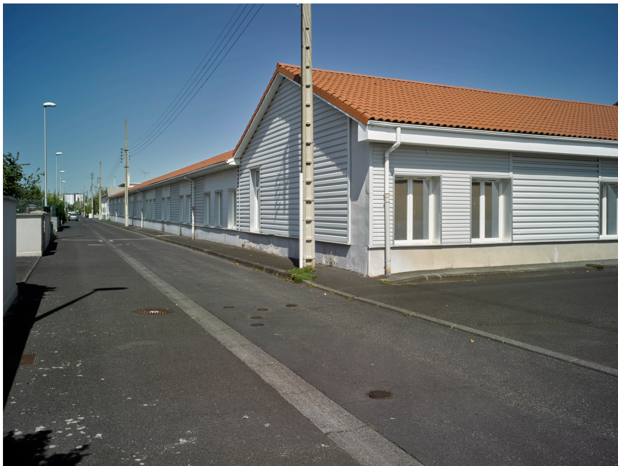
Bâtiments de l'école Diderot (cité de la Plaine).
