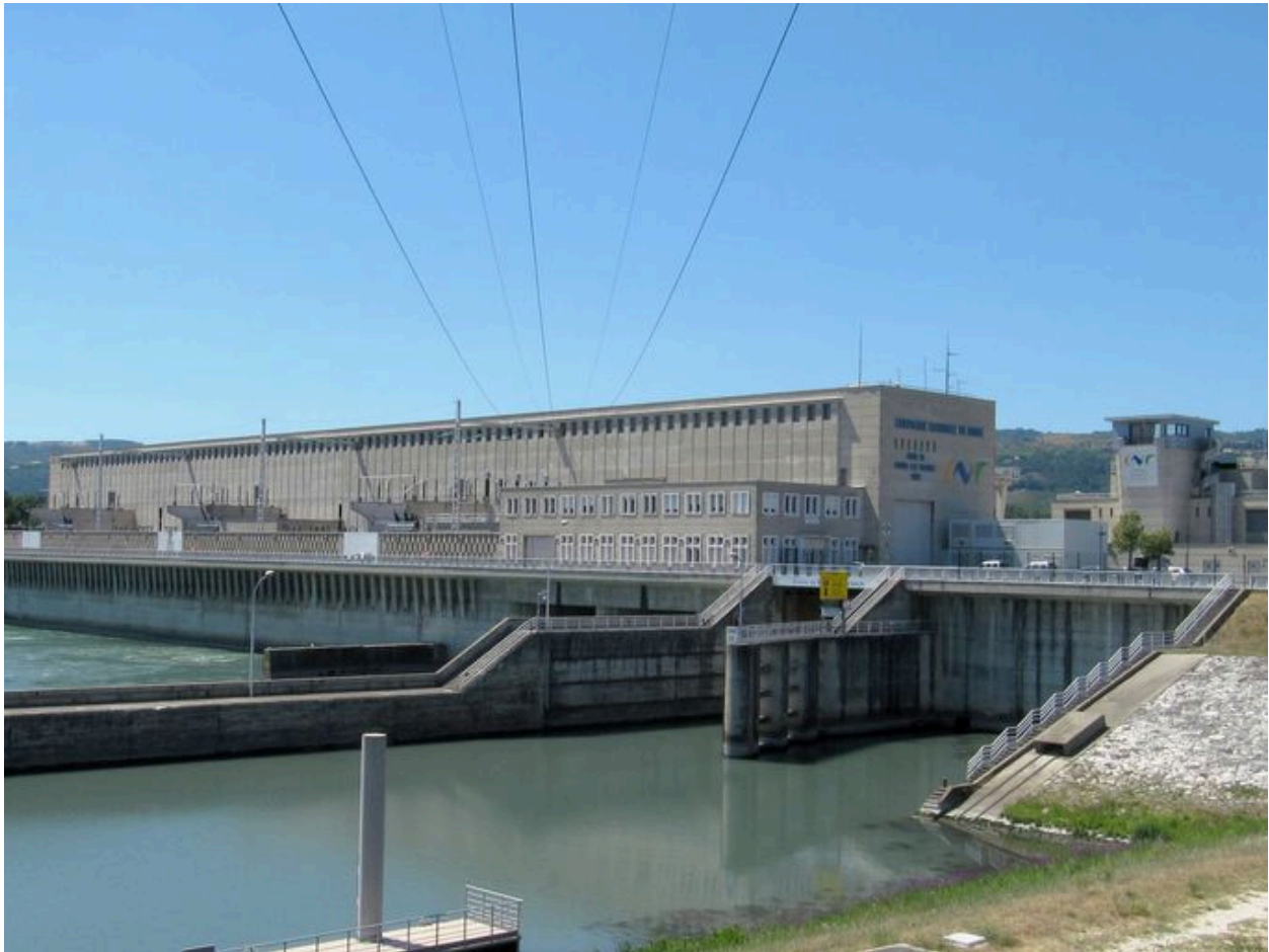
Vue de la centrale, face aval (depuis la rive gauche) ; écluse au premier plan
