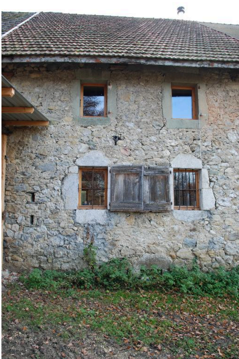
Vue d'ensemble des baies de la façade arrière.
