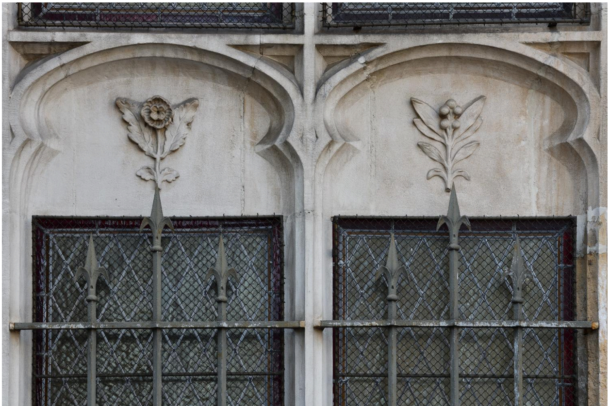
Elévation est, baie portant la date de 1904 : partie droite
