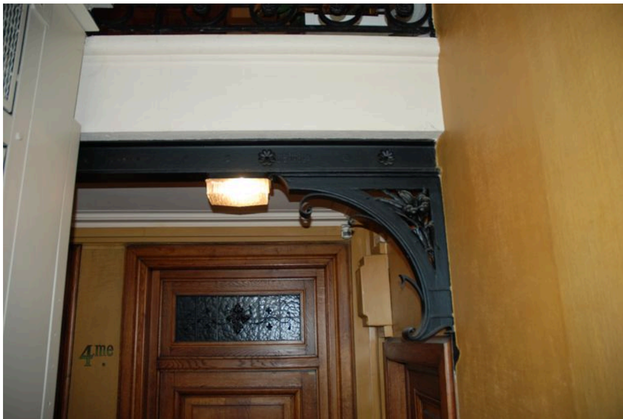
Vue d'une poutre métallique.
