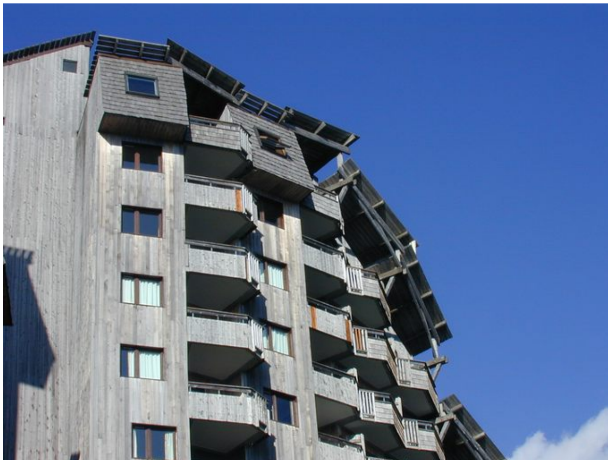
La façade sud, détail des parties supérieures
