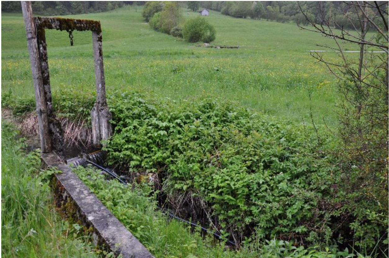
Vue du bief d'arrivée et d'éléments de vannage.
