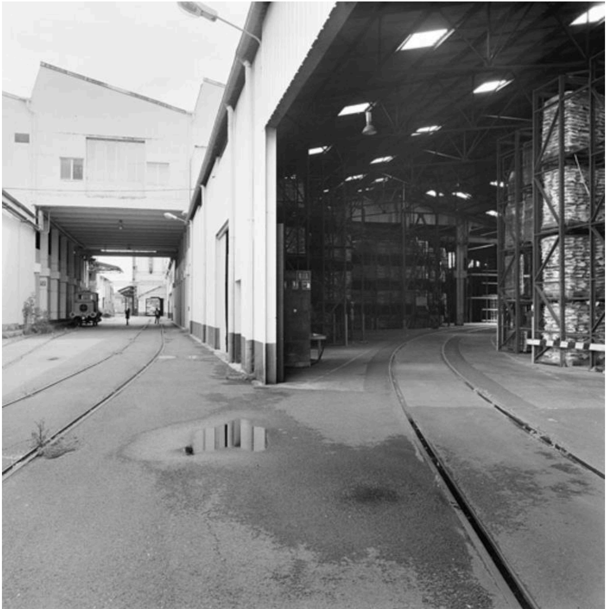
Vue interne, circulation raccordement ferroviaire
