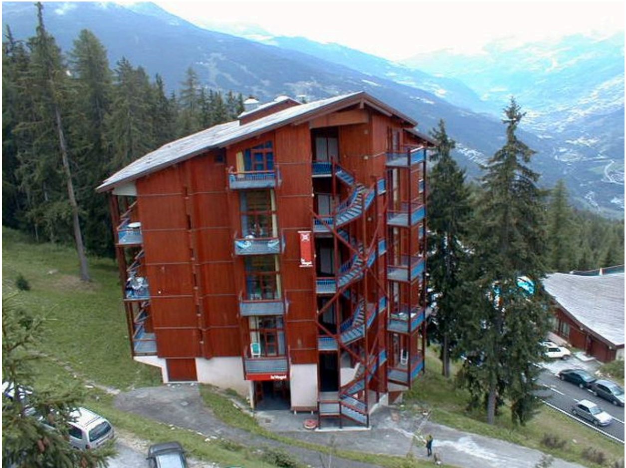
Façade nord (pignon), entrée
