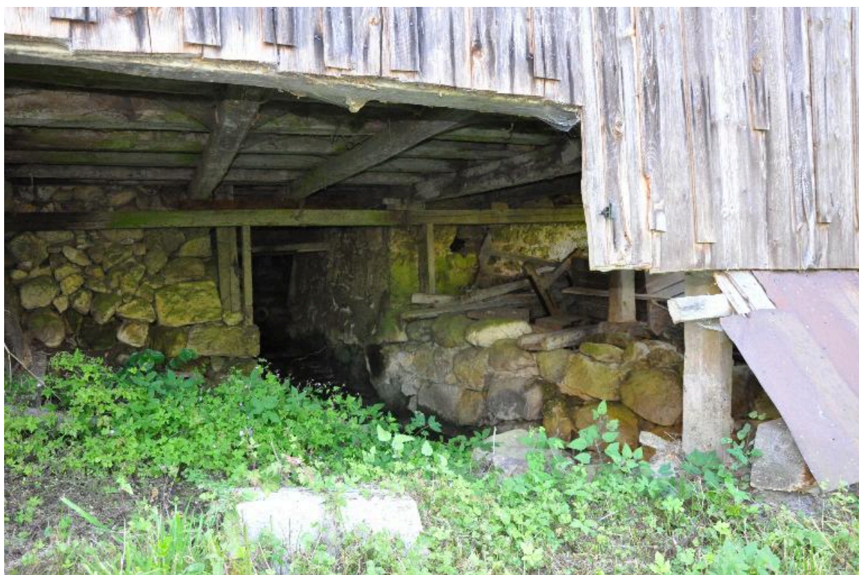
Vue du canal de fuite sous le bâtiment.
