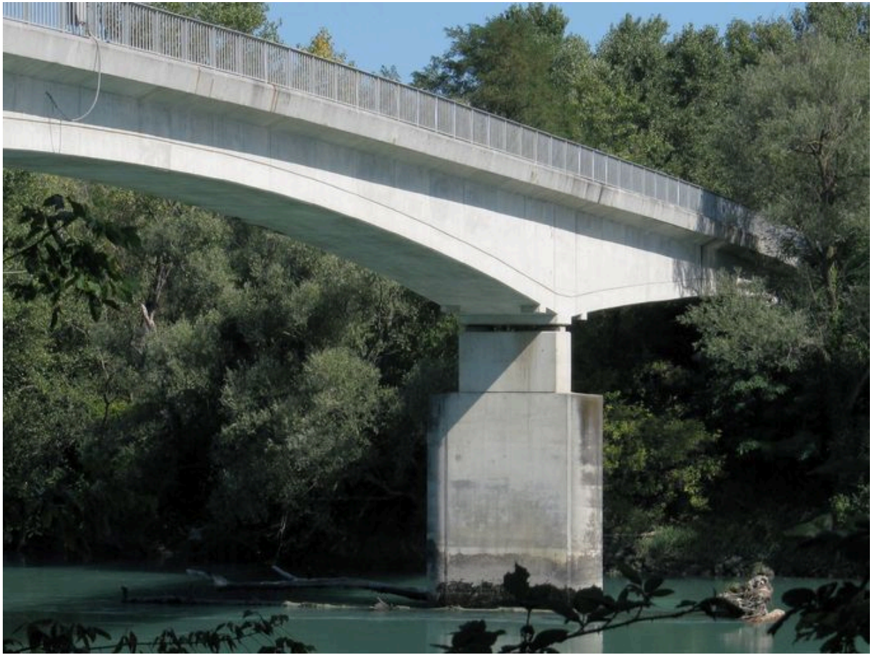
Pile, face amont (depuis la rive gauche)
