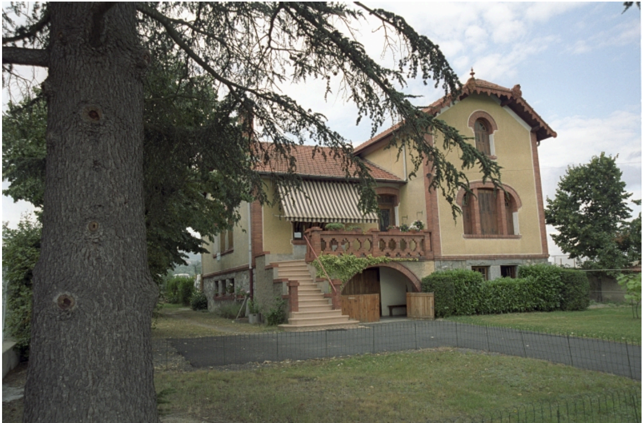
Maison bourgeoise au lieu-dit la Tuilerie (ZC 158), vue générale.
