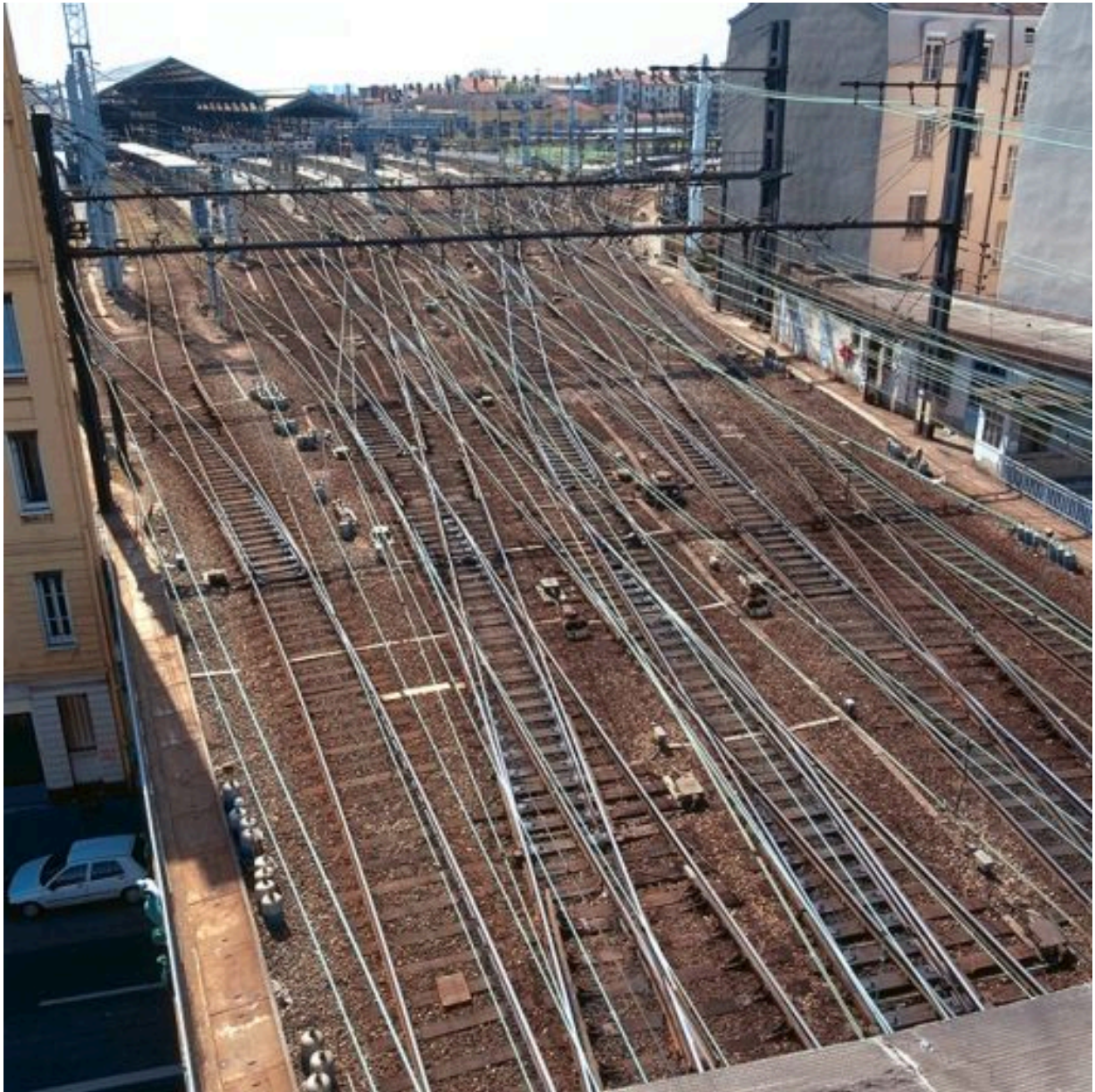
Vue d'ensemble du réseau ferré occidental depuis le poste d'aiguillage 1
