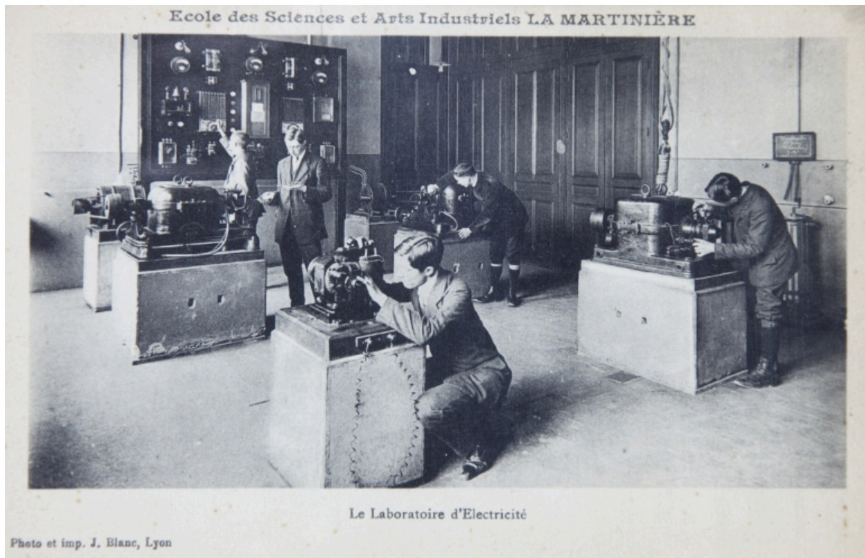
Le laboratoire d'électricité.
