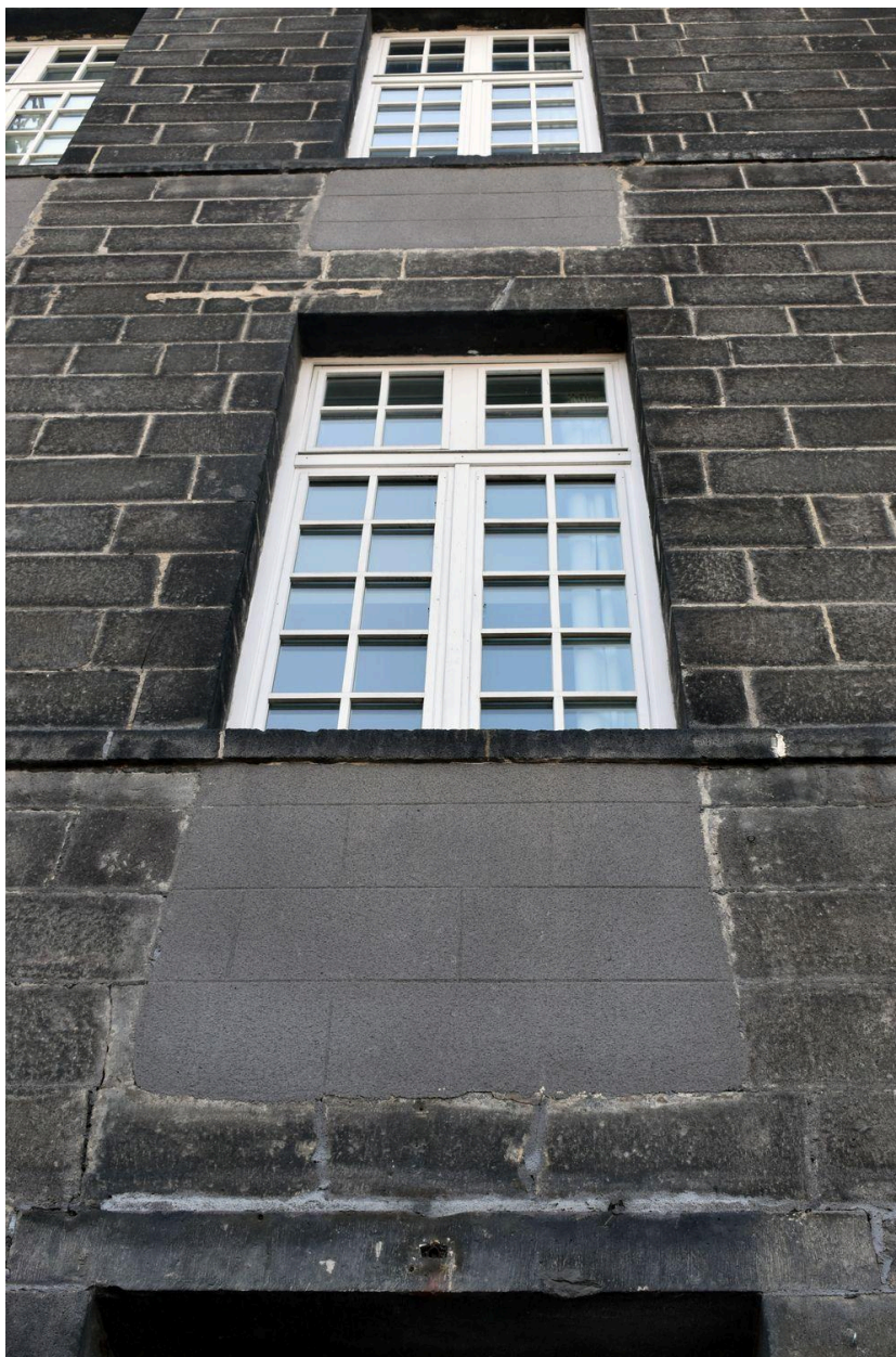
Pavillon est : détail d'une travée
