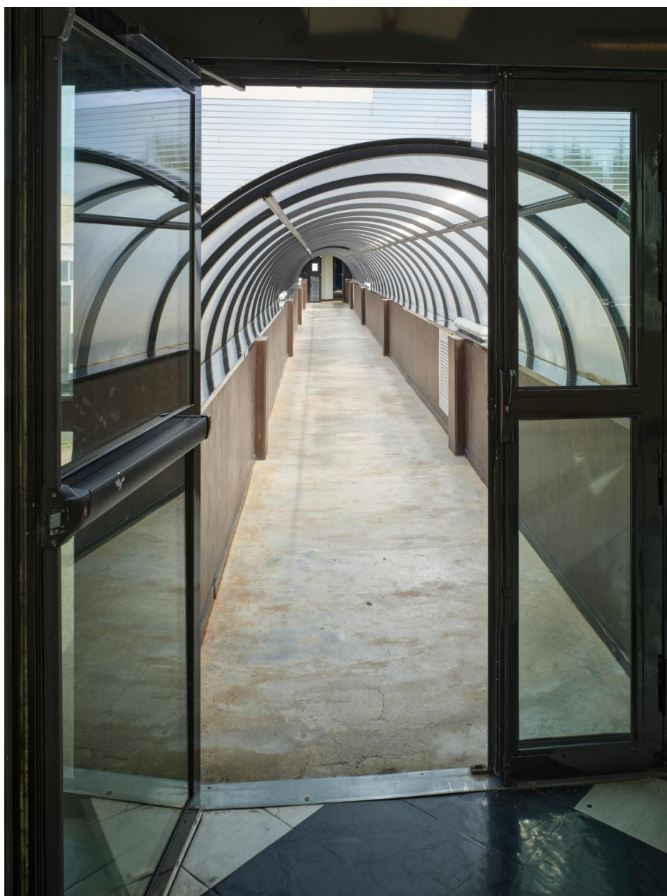
Intérieur de la galerie de liaison, depuis le bâtiment de l'externat.
