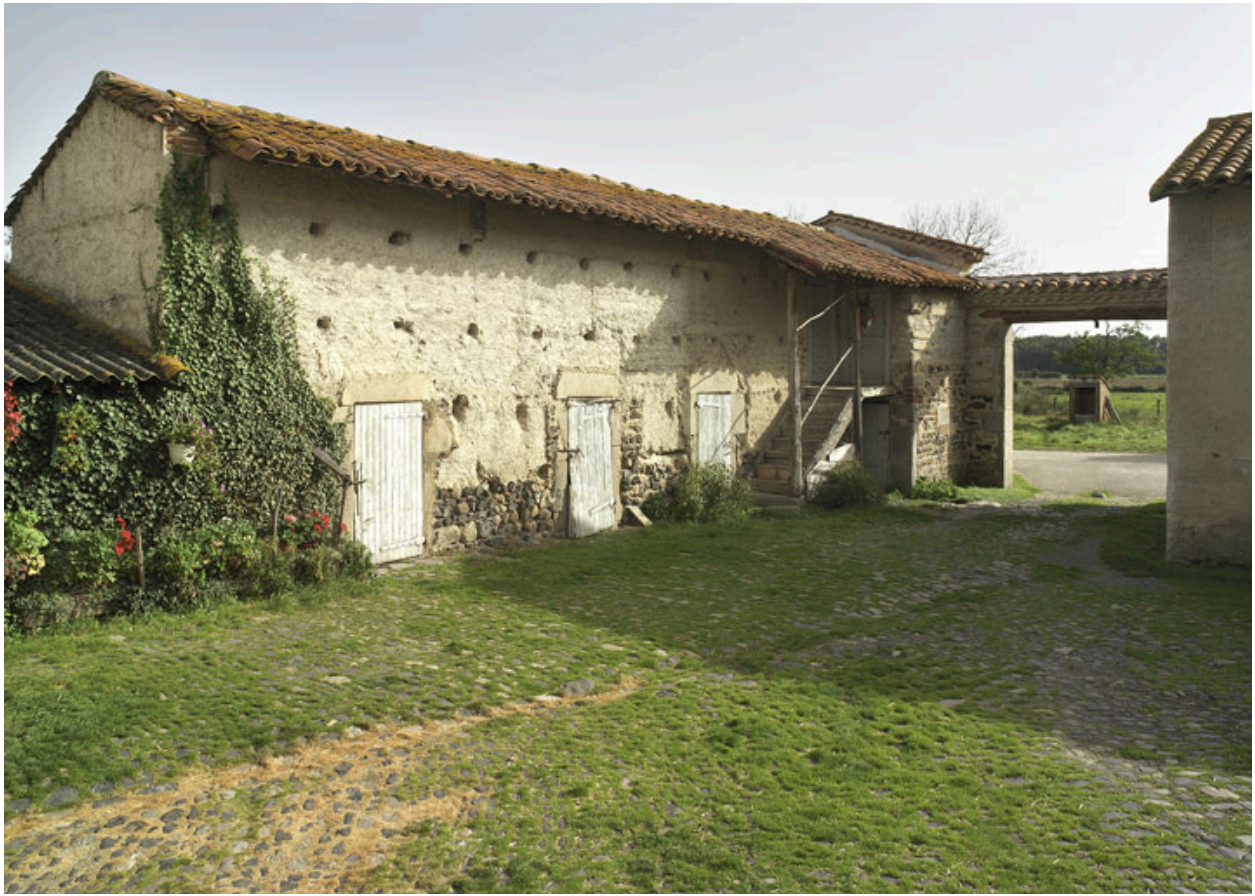
Vue d'ensemble du corps de bâtiment nord-est (porcherie, logement, grenier), depuis l'ouest.
