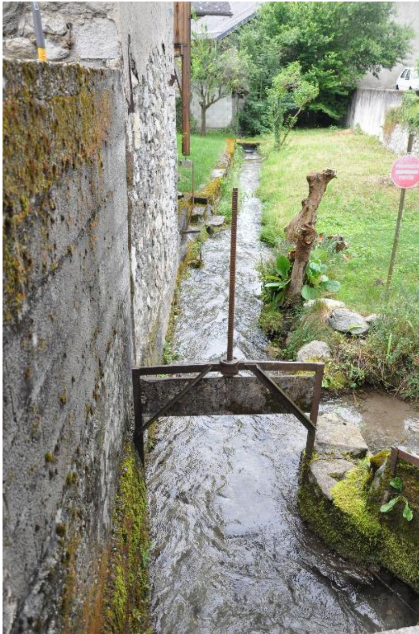
Vue d'une vanne entre le moulin Bouvet et la forge Descorps.
