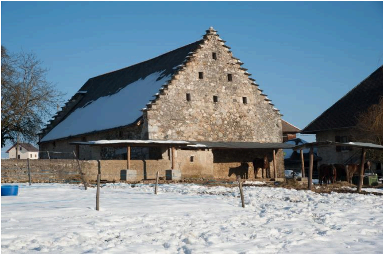
Vue de la grange-étable depuis le sud-est (pignon à redents).
