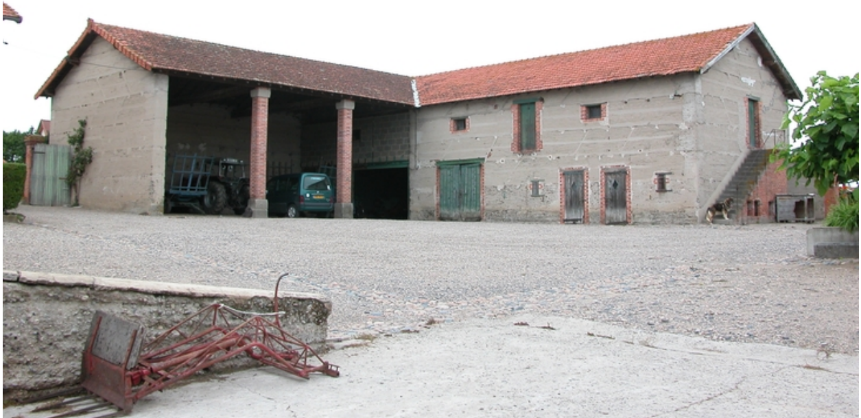
Vue d'ensemble du hangar et d'une grange-étable, depuis la cour.
