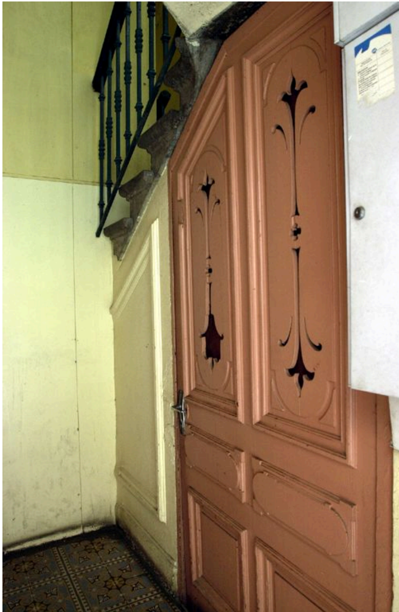
Vue du placard sous l'escalier
