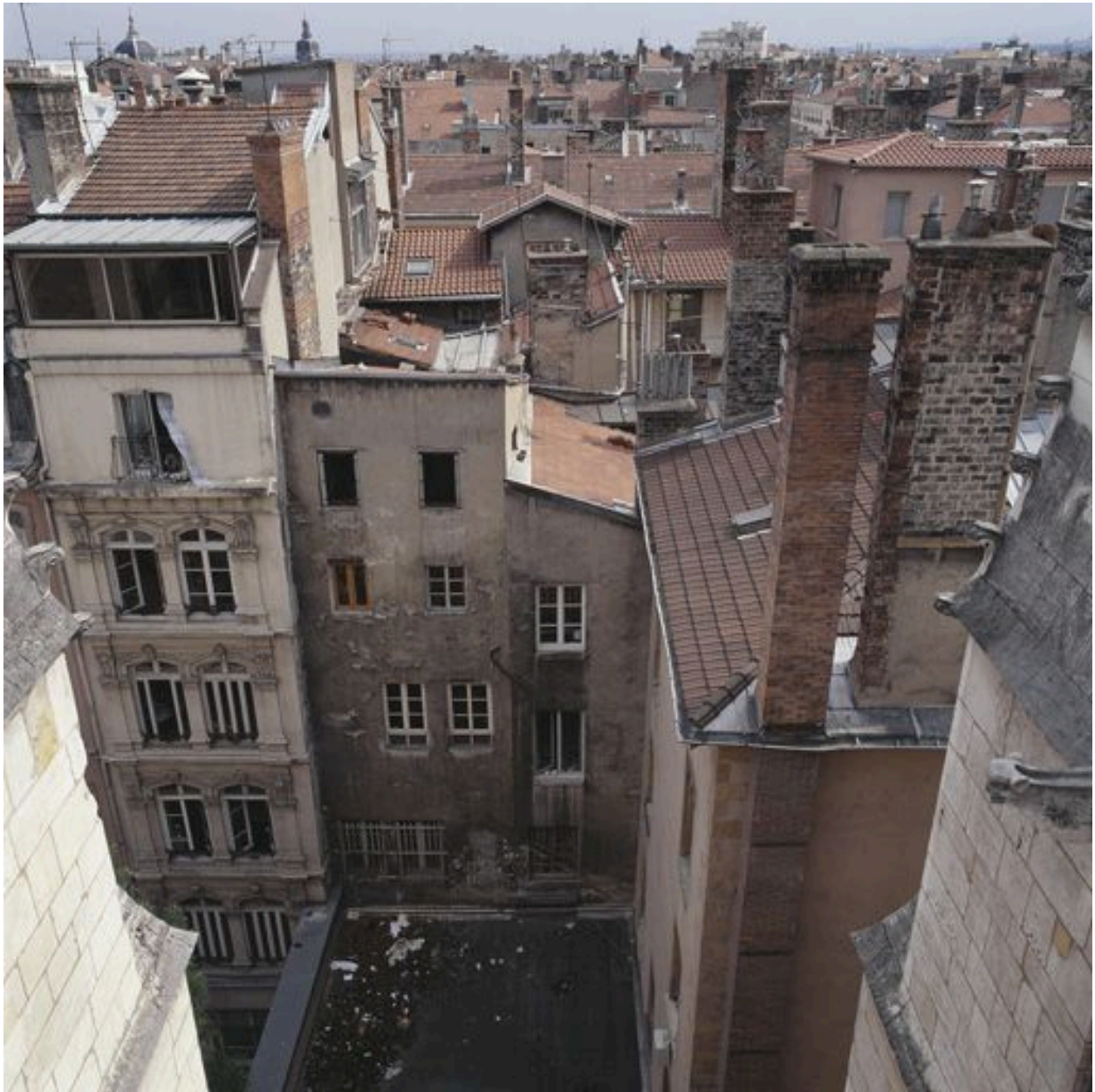
Le corps arrière sur la rue Saint-Nizier, vue prise depuis les toits de la collégiale
