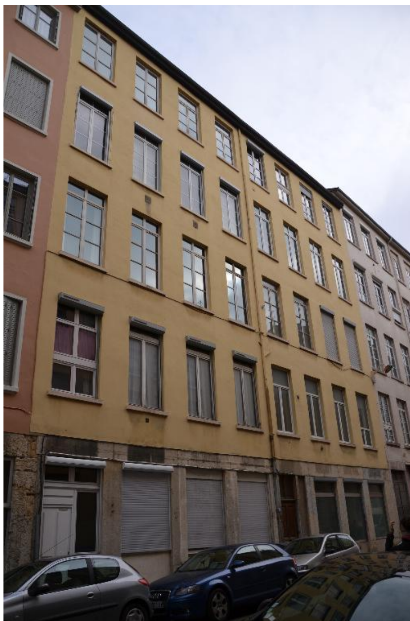
Vue d'ensemble façade sud
