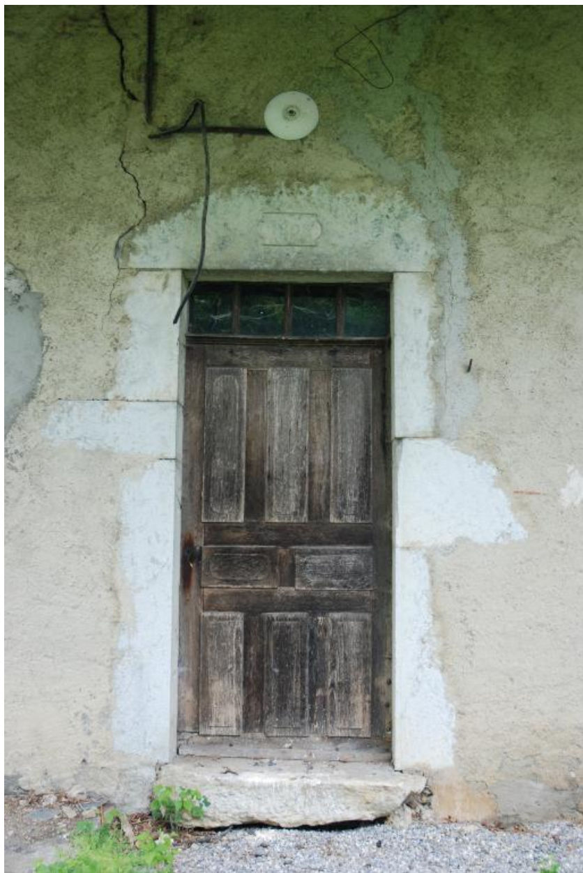
Détail de la porte d'entrée.
