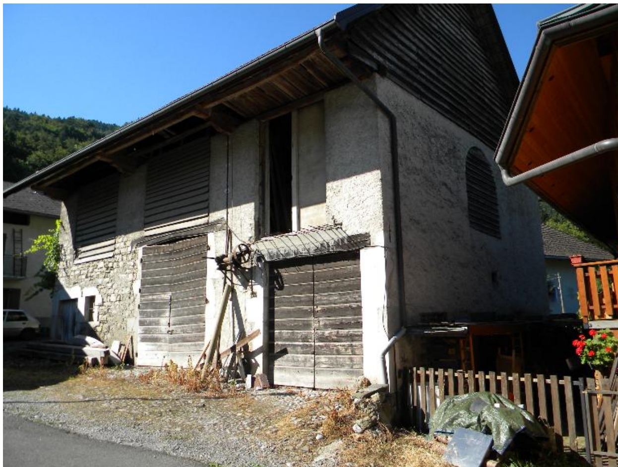
Vue de la façade est de la dépendance agricole.
