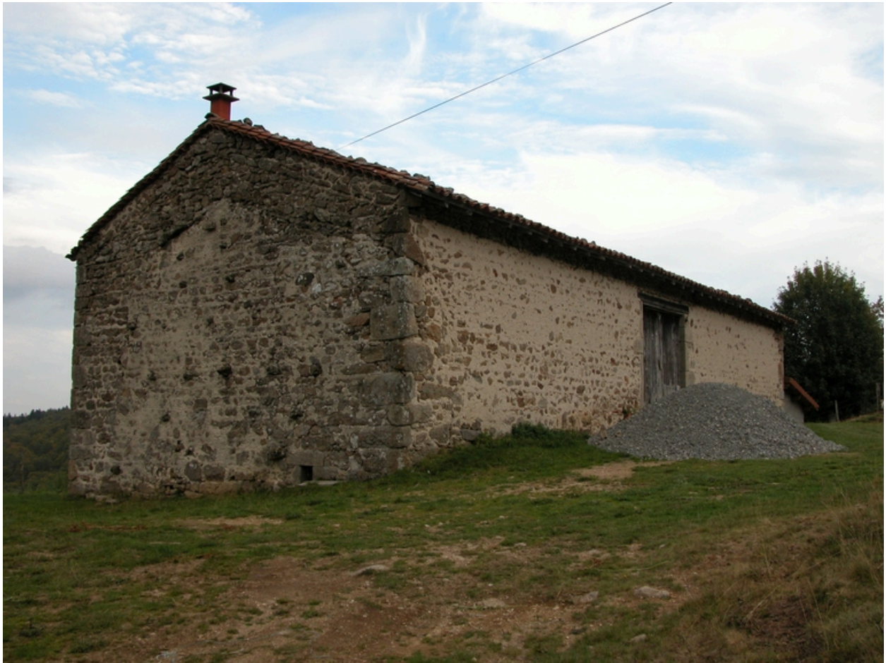
Vue d'ensemble du pignon nord et de la façade ouest.
