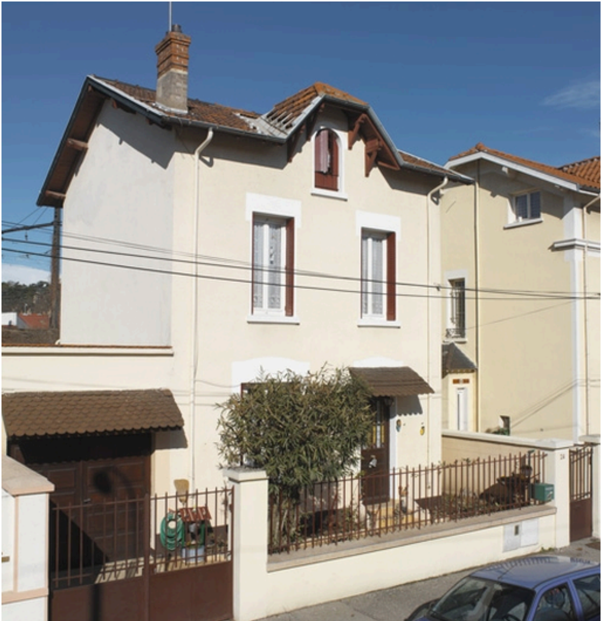
Vue sud, 24 rue Littré (BP 44), maison individuelle sur cour, entrée façade principale sud-est
