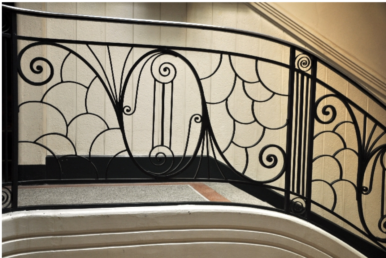
Garde-corps de l'escalier intérieur
