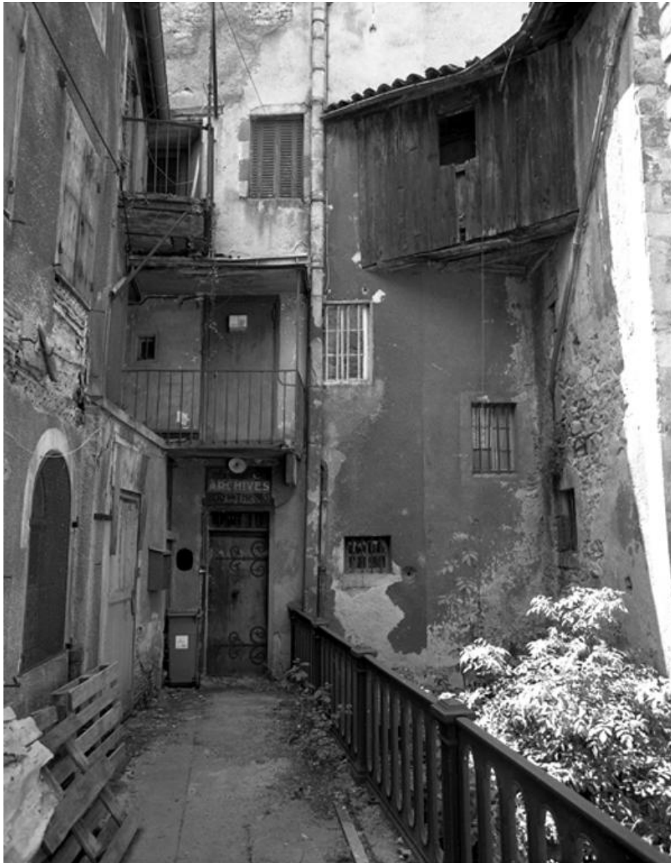
L'entrée secondaire du musée et des archives (en retrait de la rue de Barante), installés côté est, aujourd'hui en partie détruits.
