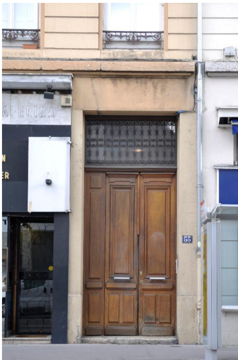
Vue rapprochée de la porte bâtarde
