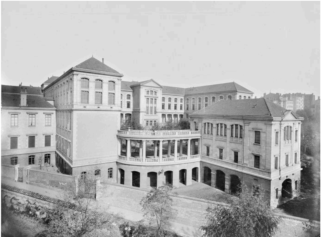
Vue de l'élévation sud-est de l'école normale (Arch. dép. Rhône, 1 T 1275, photographie).
