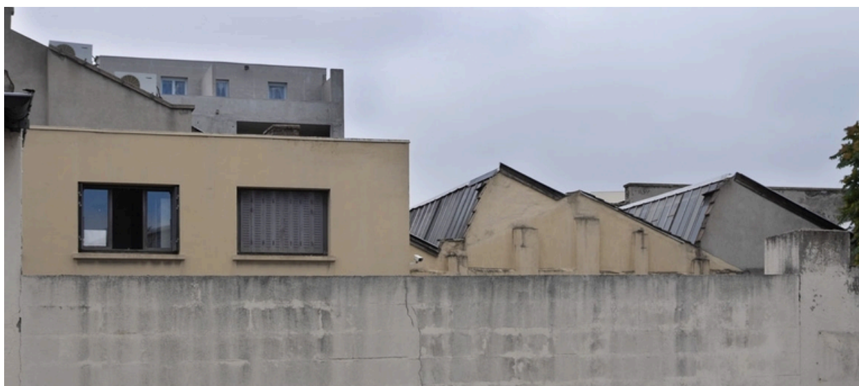
façade latérale, sheds, 58 rue Victor Lagrange
