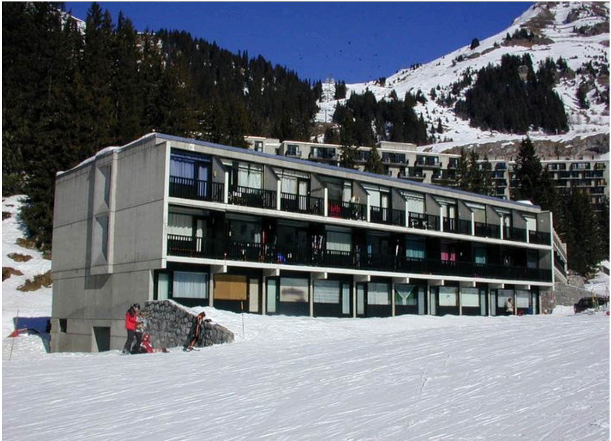
Vue depuis le sud-ouest
