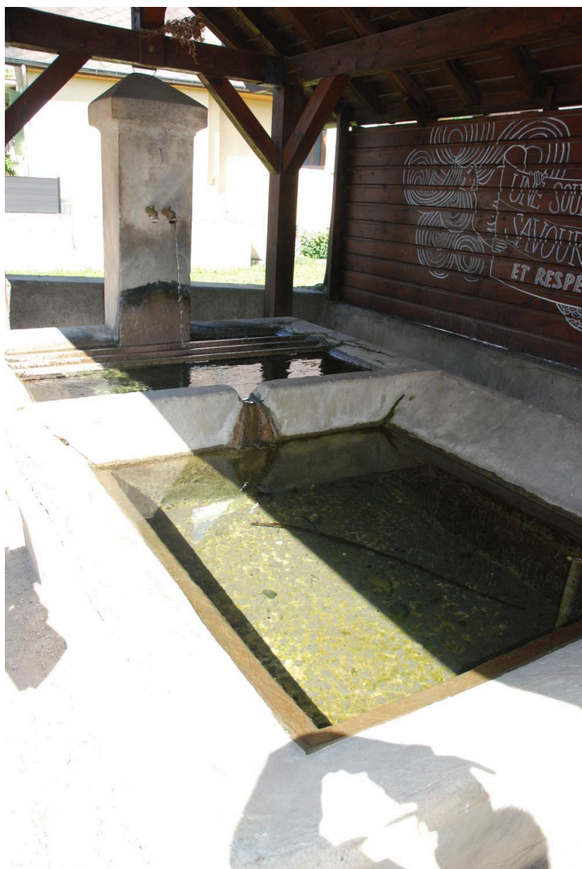
Bassin couvert (2018 C2 364). Vue intérieure.
