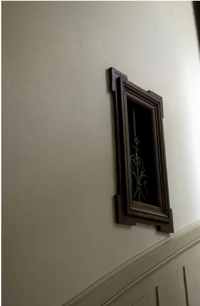
Fenêtre de second jour ouvrant sur l'escalier
