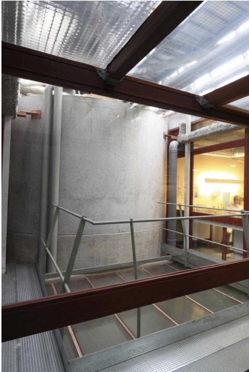
Bâtiment C, 1er étage, cuve et étage supérieur d'un puits de lumière, avec vitrage opaque et galerie d'entretien.
