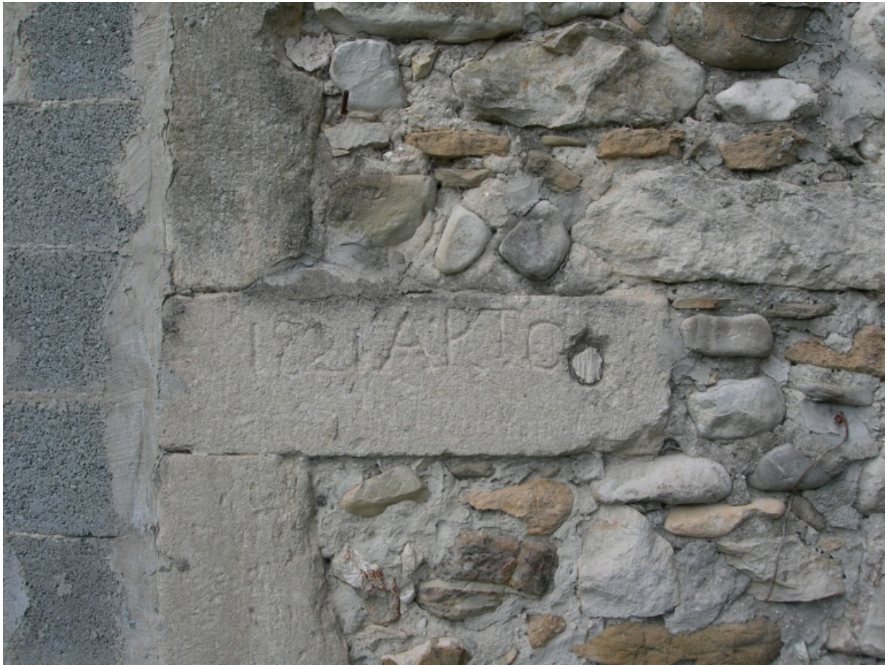
Elévation sud du moulin, détail : pierre d'encadrement d'une porte, gravée de la date 1821 suivie de l'inscription APTO.
