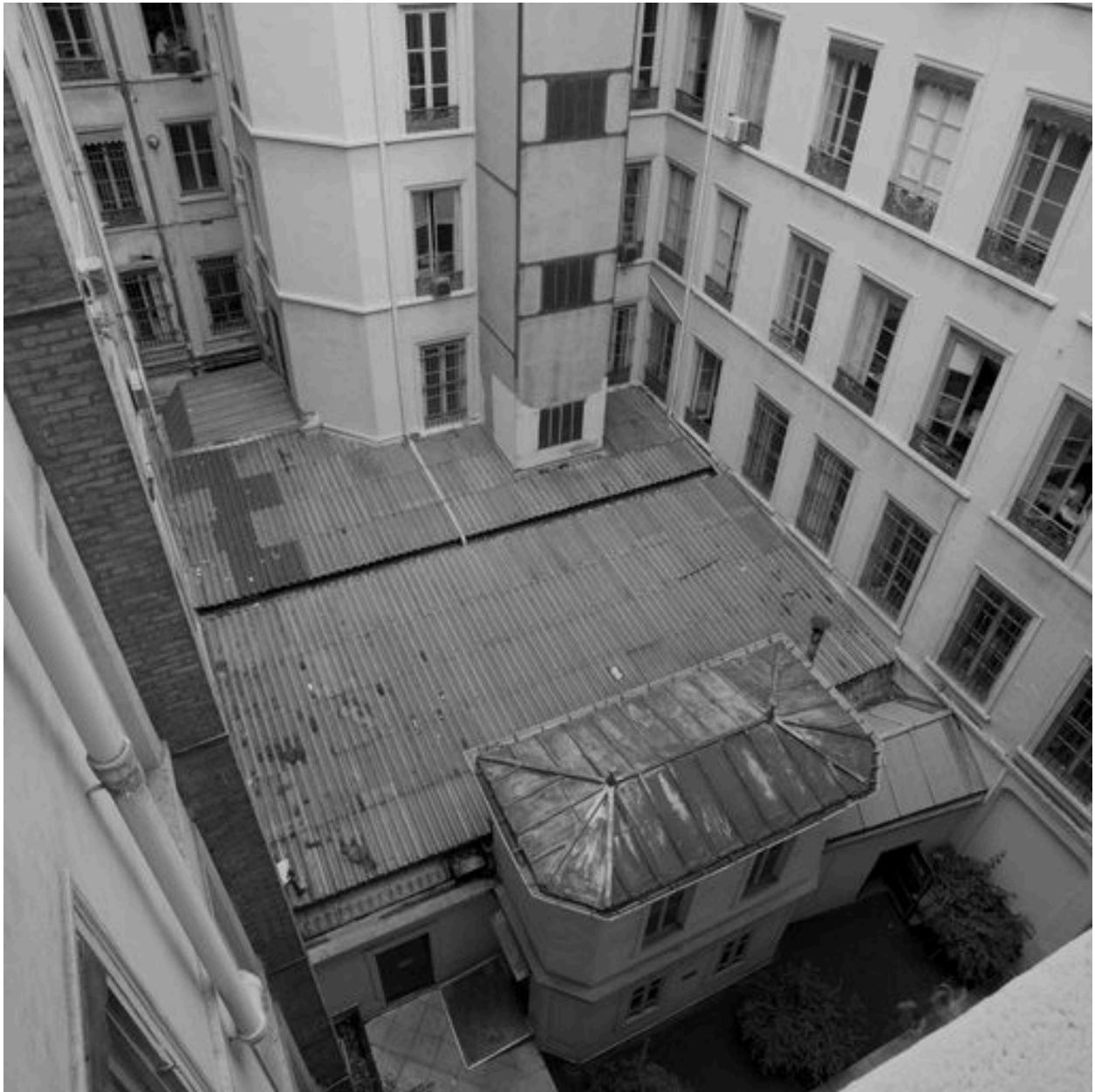
Vue de la cour et de conciergerie, depuis un étage, côté sud
