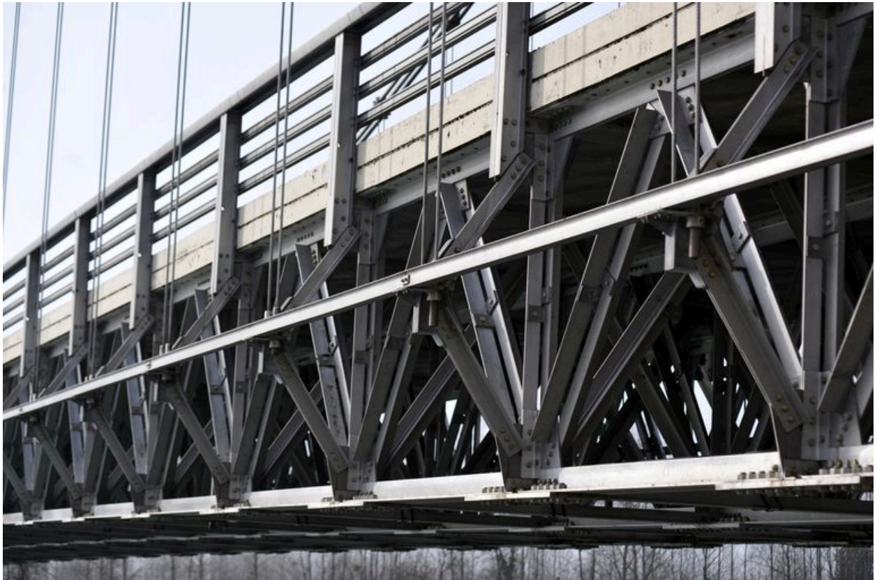
Travée centrale, face amont, vue de détail : jonction des suspentes avec la structure métallique du tablier (depuis la rive droite)
