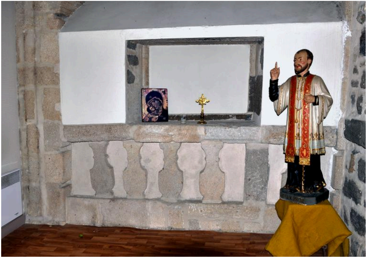
Galerie B, 1er niveau, salle 1 ; ancienne baie à balustre donnant sur la cour du collège, murée
