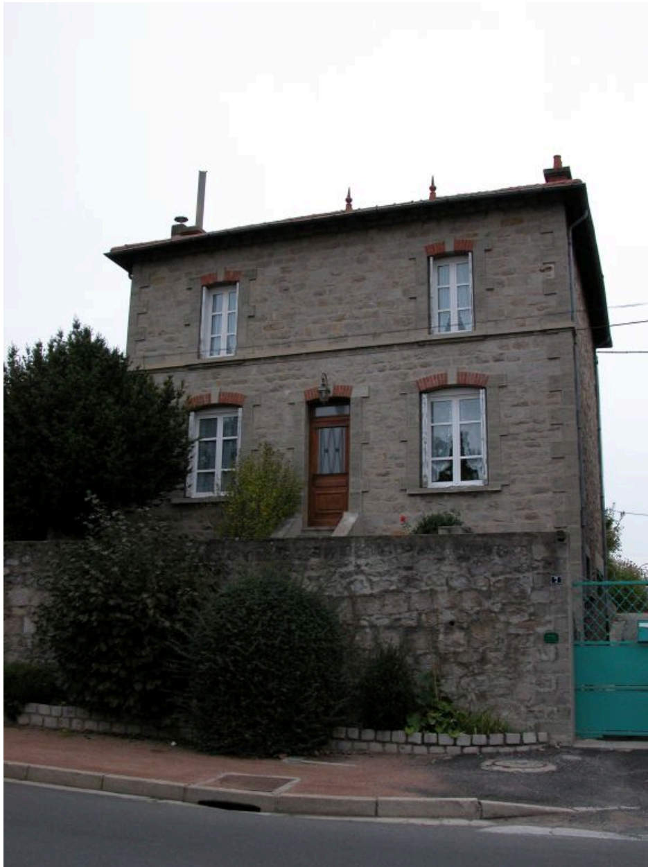
Purelles (les), maison 1986 AK 349. Vue d'ensemble de la maison du début du 20e siècle
