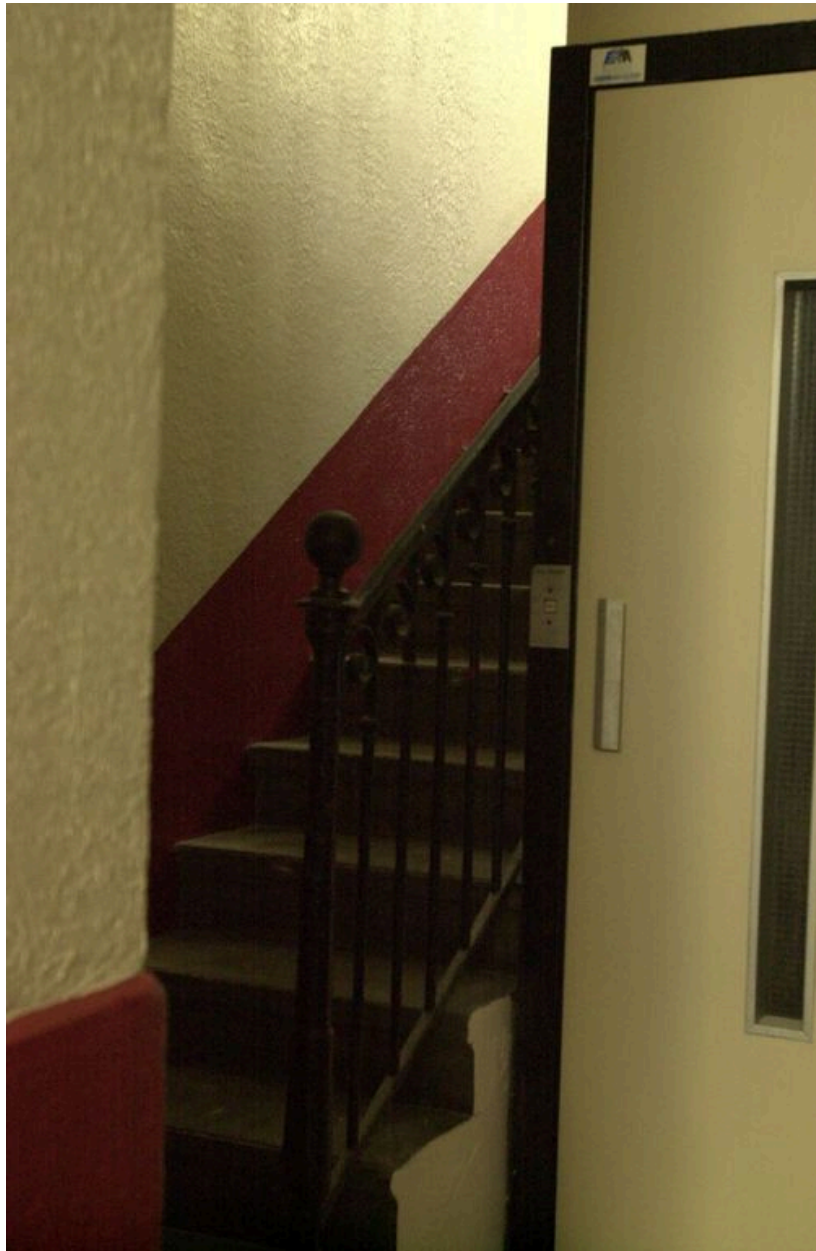
Départ de l'escalier et garde-corps à crossettes
