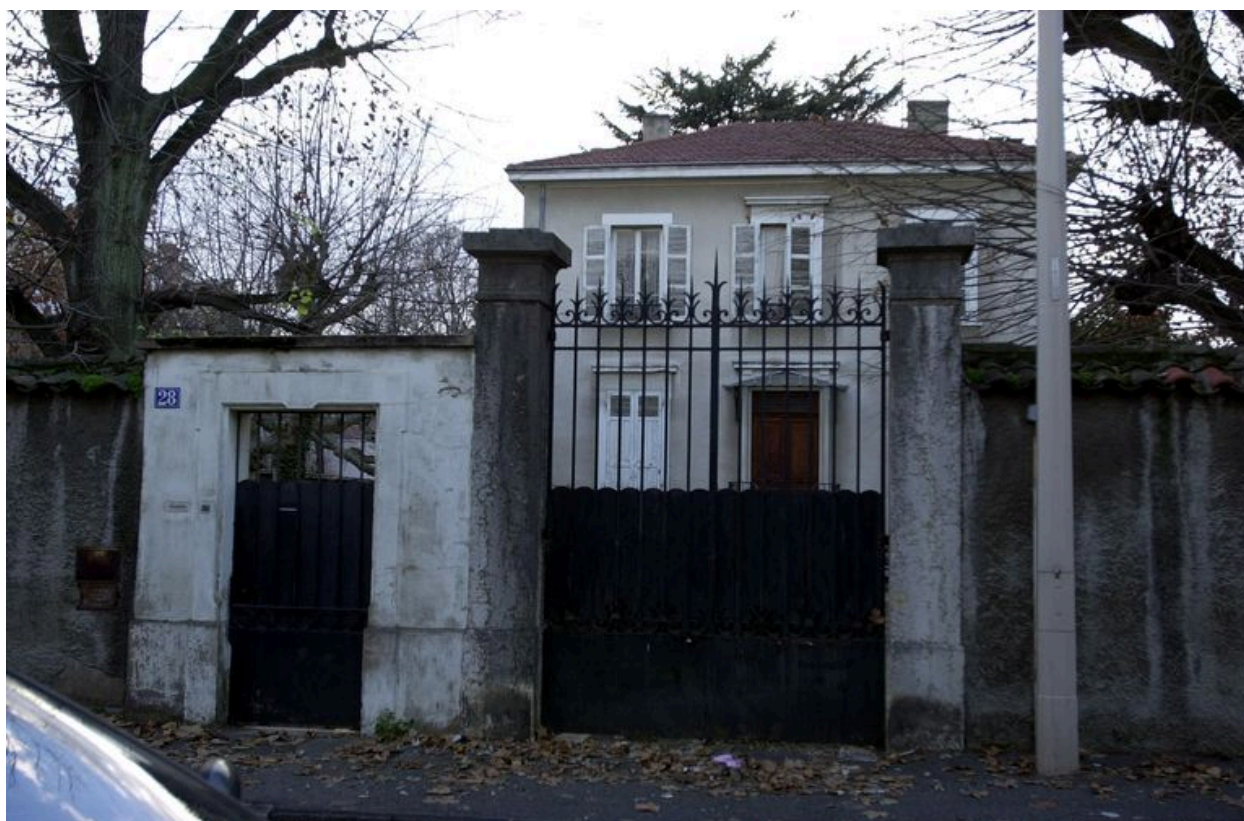
Portail et élévation antérieure
