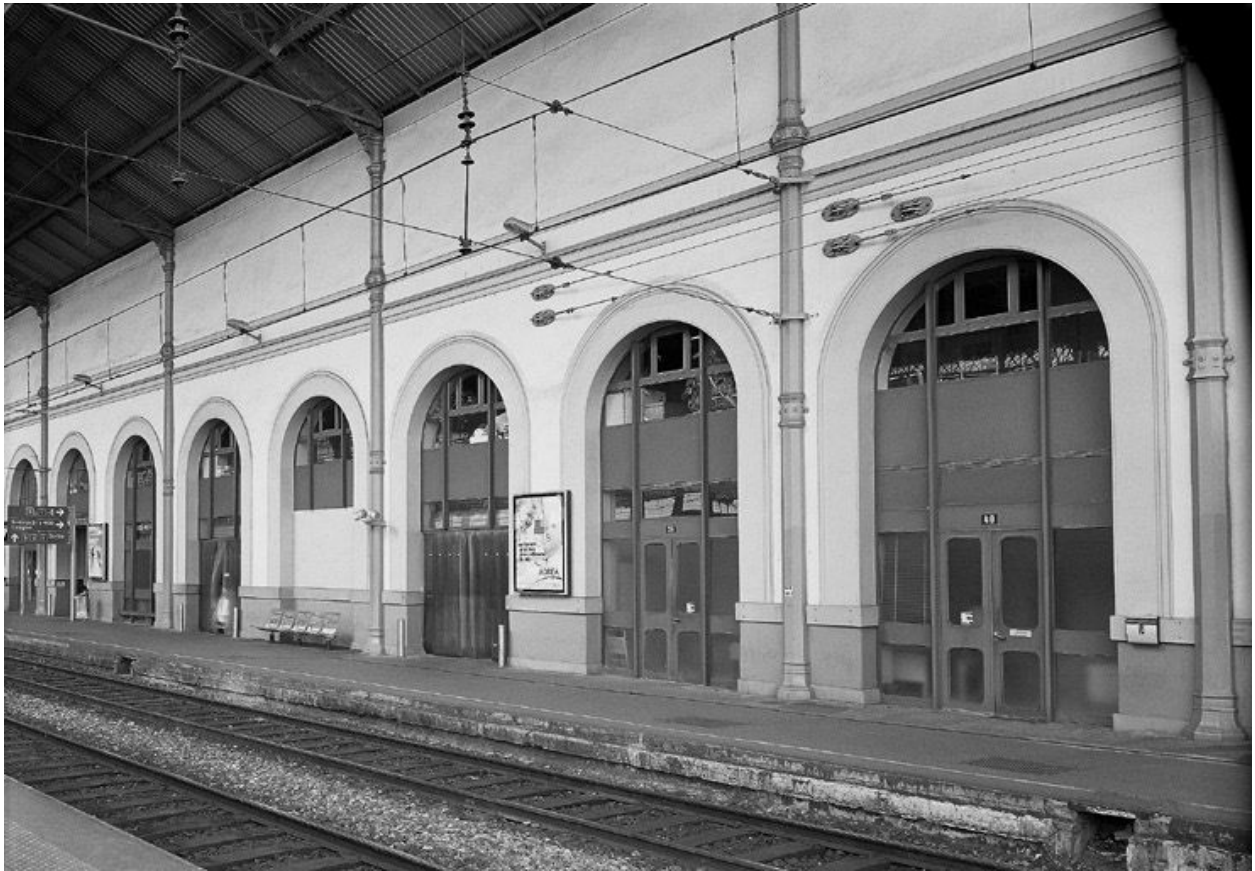
Le bâtiment-voyageurs : vue partielle de l'élévation postérieure
