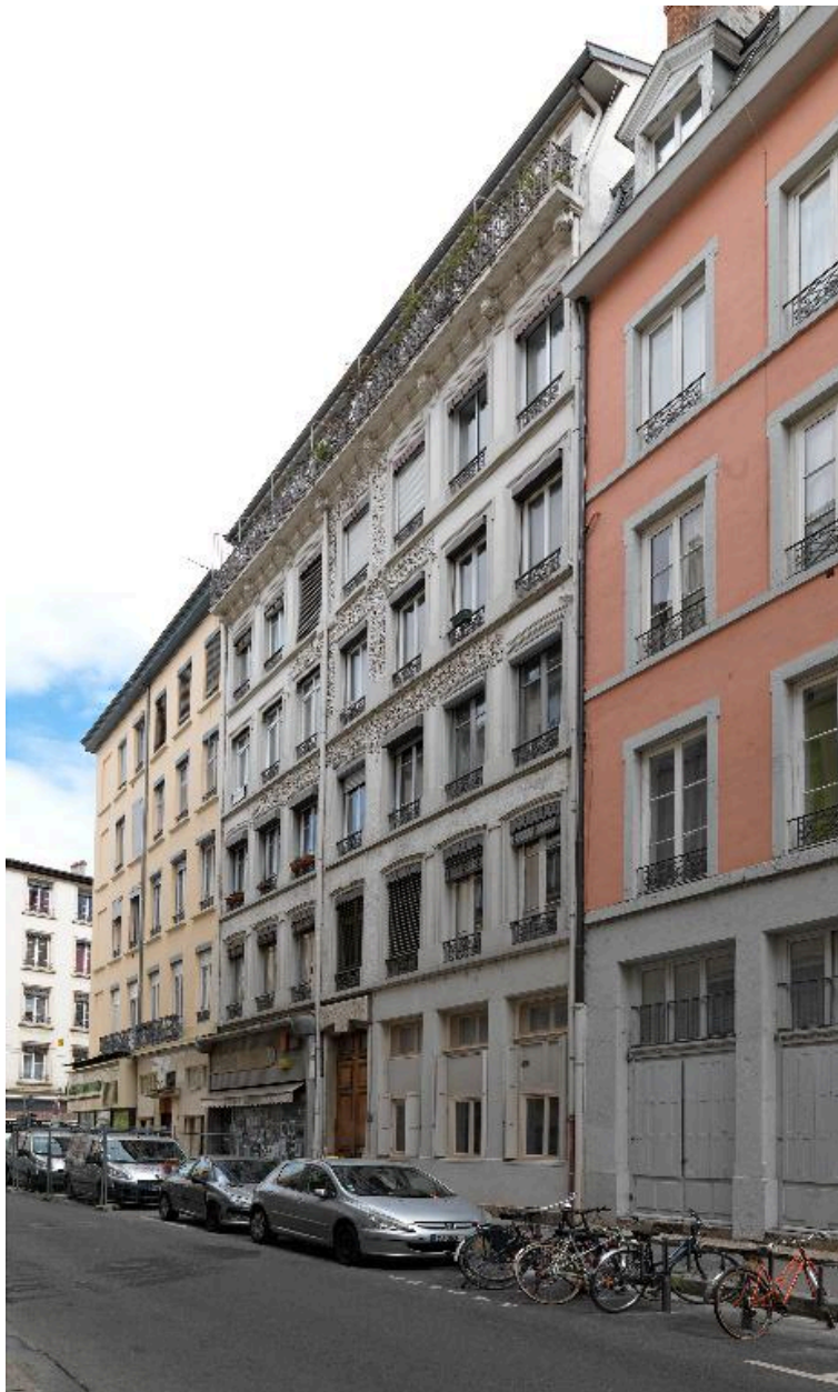
Vue générale de l'élévation sur rue
